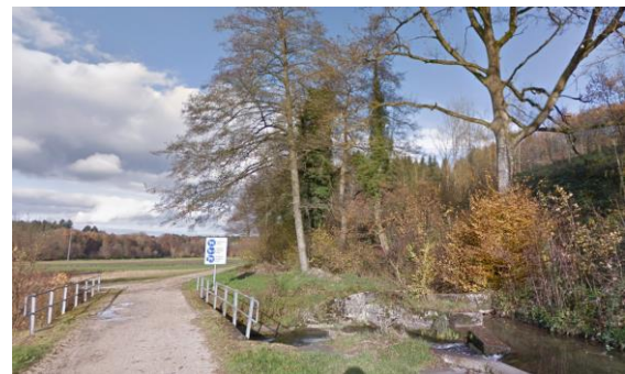
Abb. 70: Kreuzung Uerke/Dorfbach. Quelle: Google Street View, 05.12.2022
